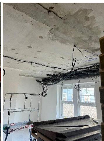
Câblage refait dans son ensemble.
